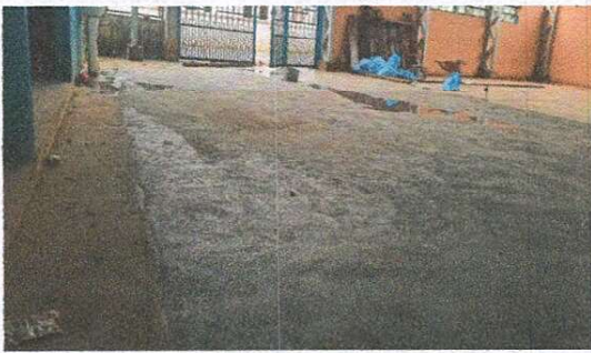
Foto 3: losa de Patio finalizado.
