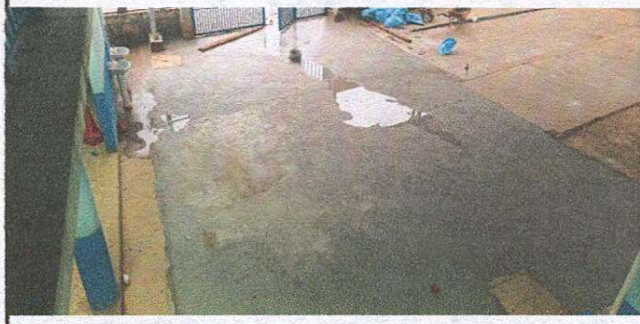
Foto 2: losa de patio finalizado
